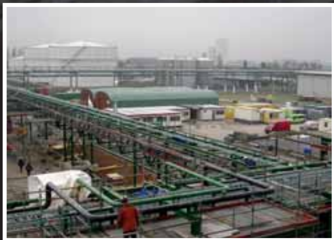
Uiteindelijk is 3,5 kilometer thermisch verzinkte buisladder verwerkt.
